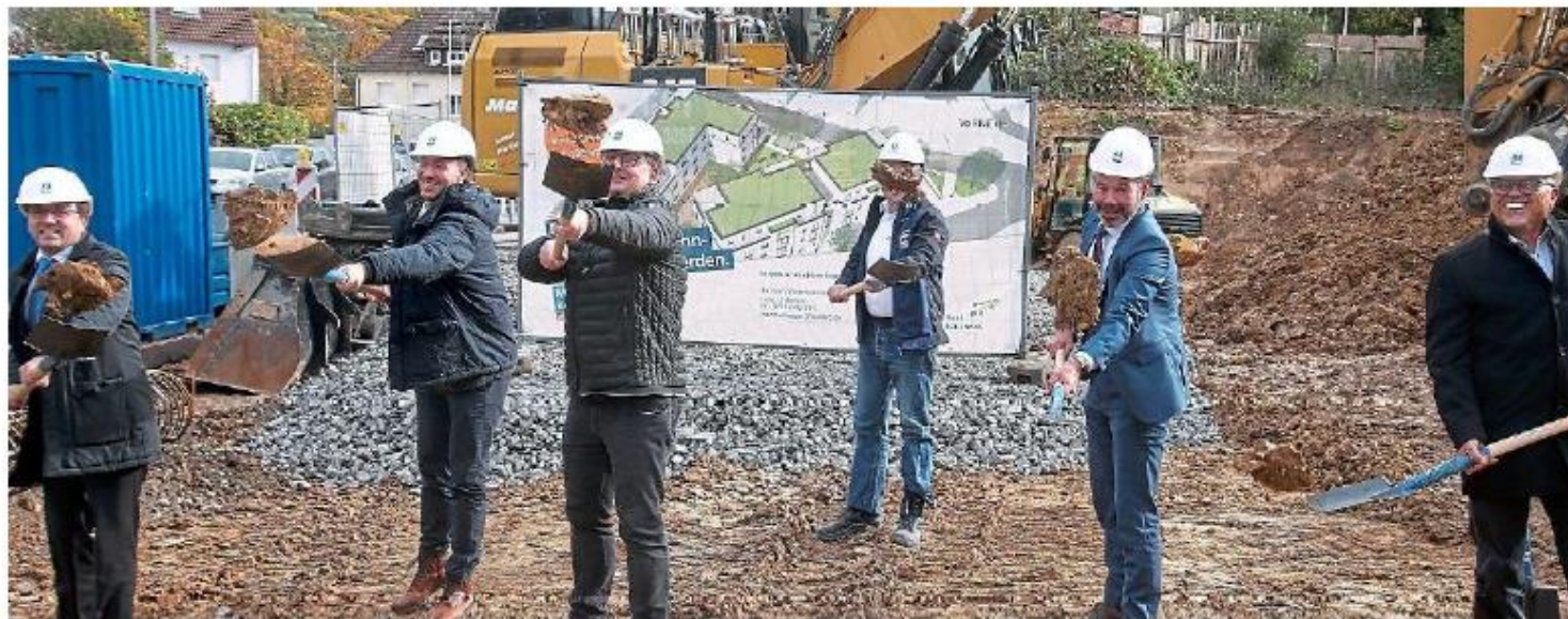
Mit Abstand: Der erste Spatenstich auf der Baustelle in der Schillerstraße.
