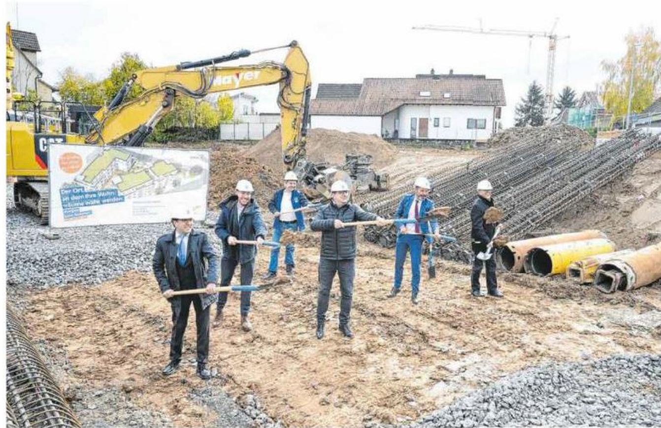
Auf dem 20 Ar großen Gelände zwischen Schillerstraße und Wilhelmstraße entstehen drei Mehrfamilienhäuser mit insgesamt 26 Wohnungen. Am Freitag war Spatenstich. Foto: Werner Kuhnle
